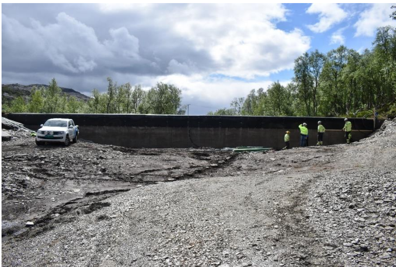
Figur 4 Ice Mate Panel montert på Oveløpsdammen med Sirkelvann.
